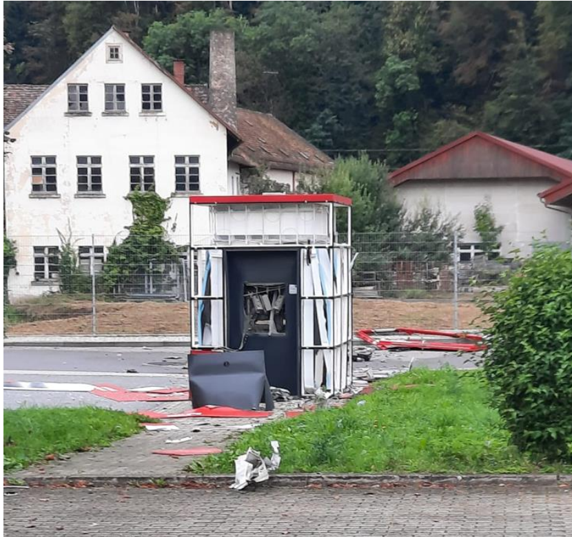
Bild vom gesprengten Automaten
